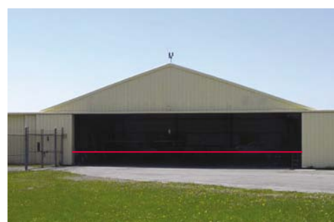
Einweg-Lichtschranke in einem Rolltor
